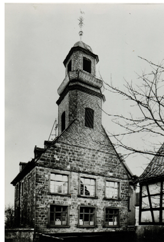
Die reformierte Peterskirche, 1757 aus Steinen der Bergkirche errichtet, 1966 abgebrochen
