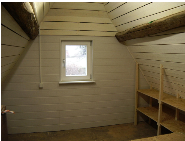
Horst Rossmann baute die neuen Giebel- fenster und die Verkleidung ein
