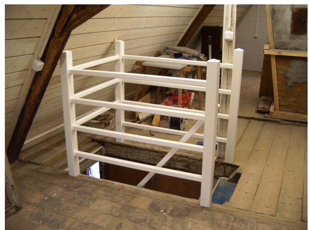
Das neue Treppengeländer
