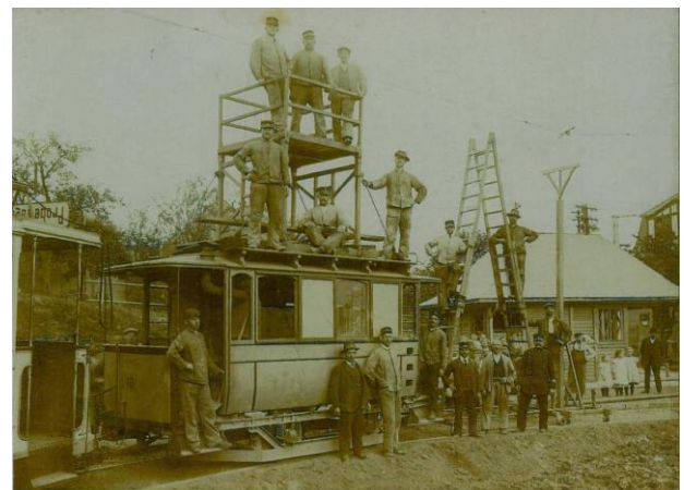
Bautrupps beim Bau der Elektrischen auf der Strecke nach Bergen.
