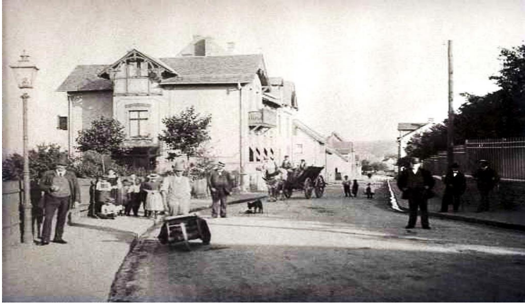
Bild 5 zeigt das Haus Nr. 38, gebaut um 1898, der Bauantrag lief unter „Bau der Villa Henrichsen“. Das Haus ist heute noch so vorhanden.
